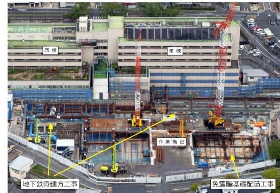
現在、新病院建設中
