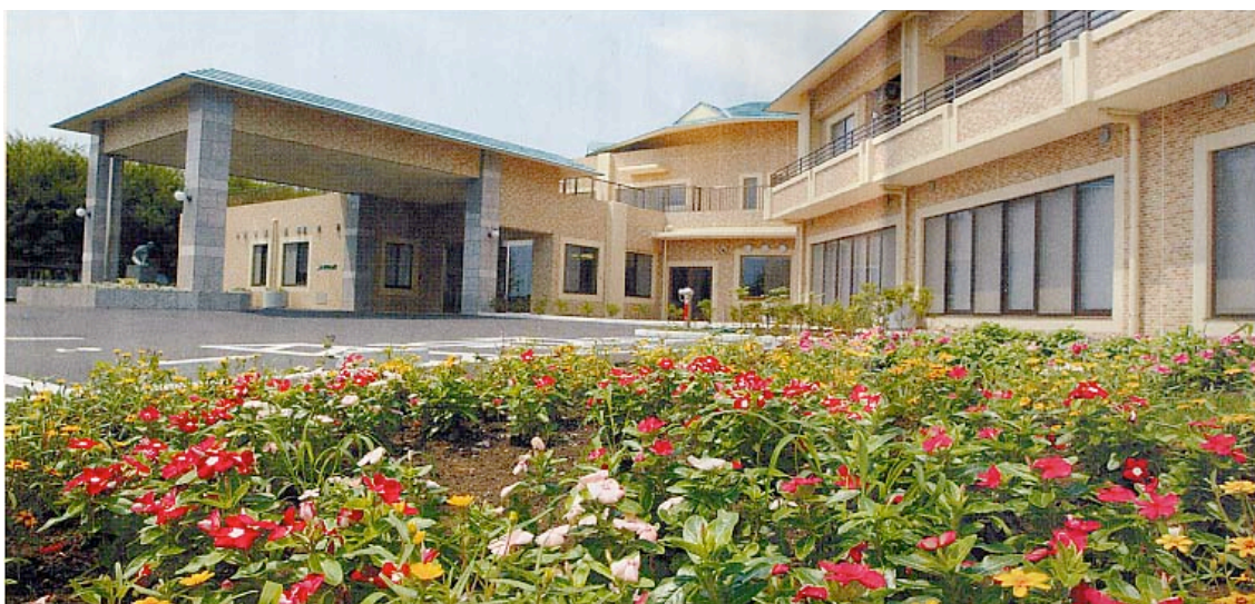
平成 17 年 8 月に開設された土浦晴山苑（常陽新聞より）
