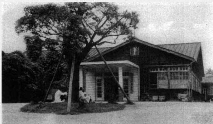
木造とコンクリートの校舎に囲まれたスペースは学生たちの憩いの場であった
