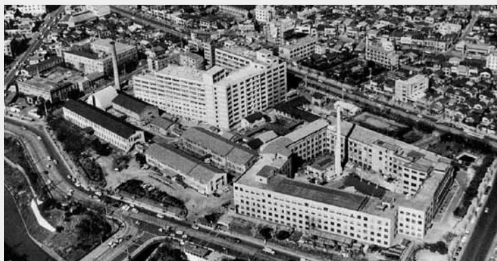
御茶ノ水駅側に新館が増築され、口の字型となった
