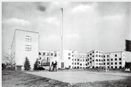
本館の構造は地上3階、地下1階のコンクリート造りとなっており、湯島の地に白亜の本格建造物が威容を放っていた
