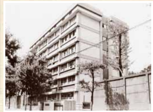
1967(昭和42)年、建物が竣工し湯島地区から駿河 台地区に移転したばかりの頃の医用器材研究所
