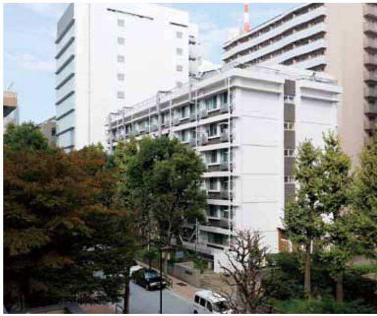
1967(昭和42)年に竣工し、2009(平成21)年には大規模改修を行った生体材料工学研究所。道向かいにある東京都教職員互助会三楽病院3階から2011(平成23)年11月2日に撮影
