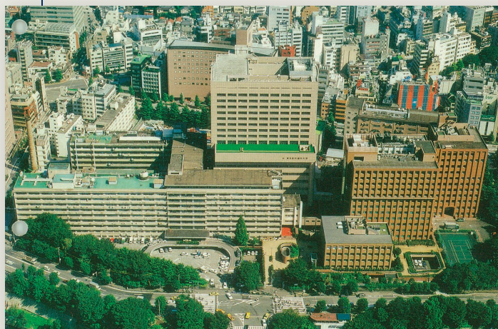
医学部創立50年頃。1991年に完成した医科A棟がそびえ立つ。
