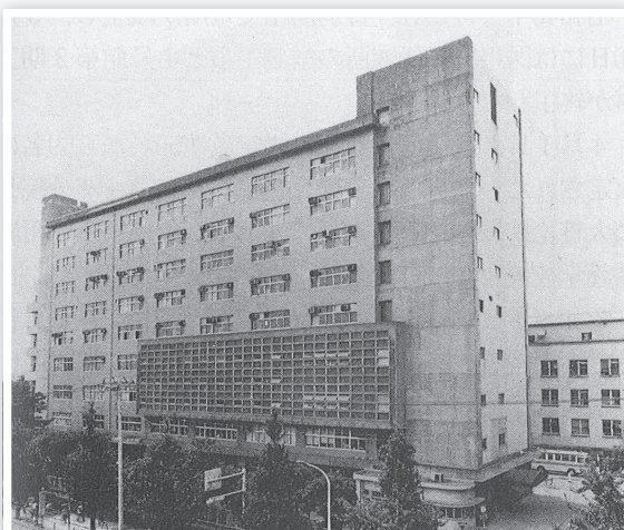
1号館(管理棟)の竣工
