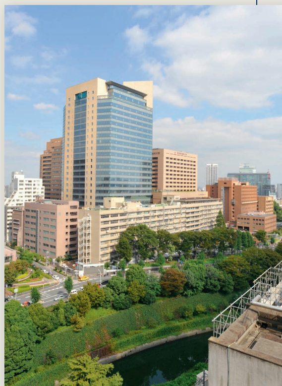
M&Dタワー完成間近。研究分野の枠組みを越えた基礎・臨床の融合および医学・歯学の連携の環境が整う。地上26階、126mの超高層研究棟最上部にはLED照明による大学名とシンボルマークが点灯し、24時間稼働する医療の最先端拠点としての存在感を示した。
