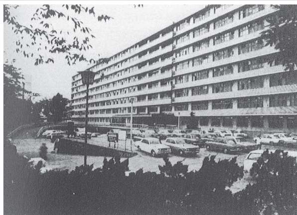
医学部附属病院中央診療棟および研究棟(1967年)
