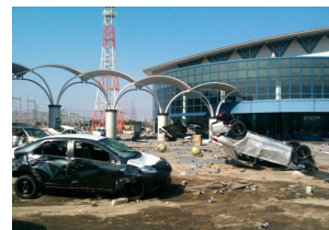
津波被害の様子。
