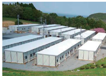
戸倉自然の家の仮設住宅。
