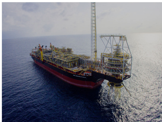
写真 1) 海洋石油・ガス生産中の MV25 社 FPSO (提供：三井海洋開発株式会社)
