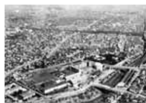
湯島地区全景(昭和27年頃)
