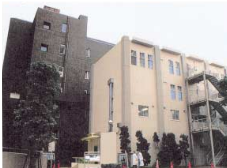
5号館 Building No.5
