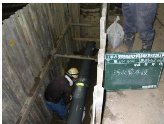
於：湯島地区 2011年度の排水管の更新工事 老朽化、劣化した排水管を更新しました。
