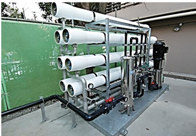
井戸水を利用した地下水膜ろ過システム
