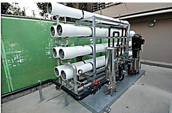
井戸水を利用した地下水膜ろ過システム
