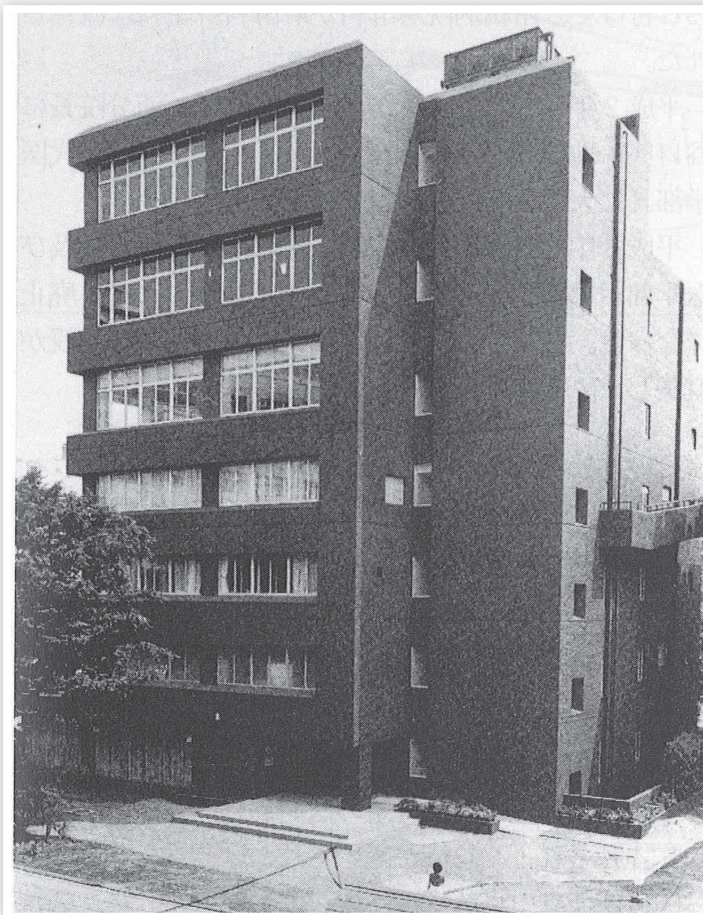
5号館(厚生棟)の落成
