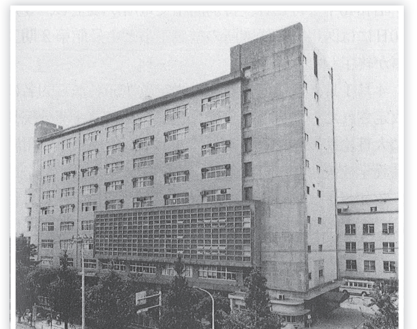
1号館(管理棟)の竣工
