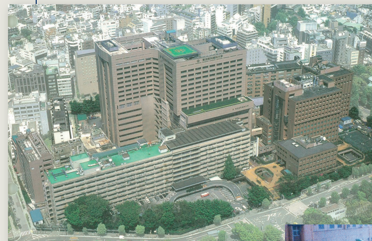
新3号館建設のため第2病棟が解体され更地となる(上)。第2病棟解体の様子(右)。
