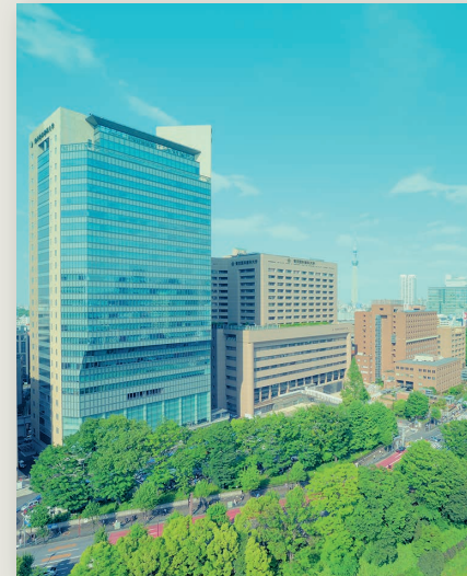
旧3号館がすべて取り壊され、M&Dタワー前の駐車場工事が進む。翌2013年に駐車場屋上庭園「知と癒しの庭」が完成した。
