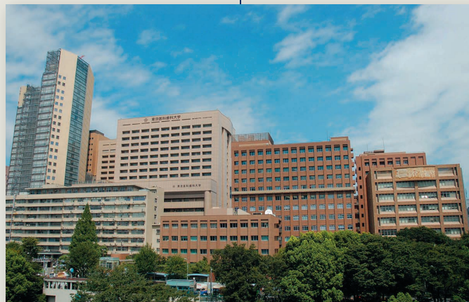
M&Dタワーの南側鉄骨工事。医学部附属病院にERセンターが開設。
