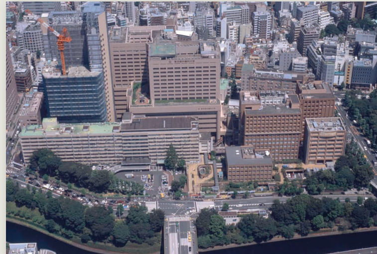
M&Dタワーの前面の工事が進む。救命救急センター(ER)に認可される。
