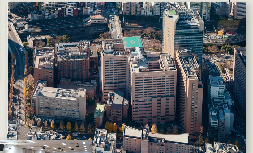
医学部附属病院のヘリポートが完成、大型ヘリコプターの離着陸が可能に。東京都の災害拠点病院としてさらなる医療の向上を目指す。
