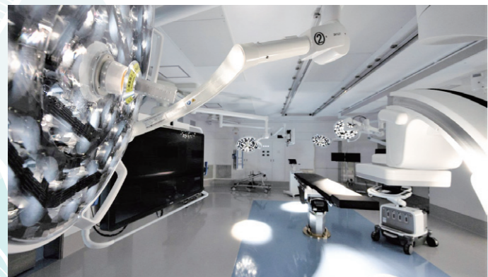
工事中のC棟 6階手術室
