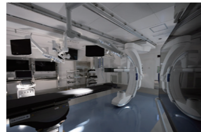
工事中のC棟6階手術室
