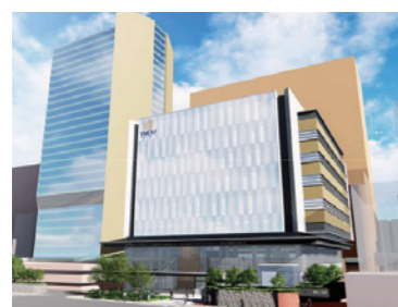
医学部附属病院と歯学部附属病院の機能を効率的に医療現場に生かすために「機能強化棟」の建設を進めています。
