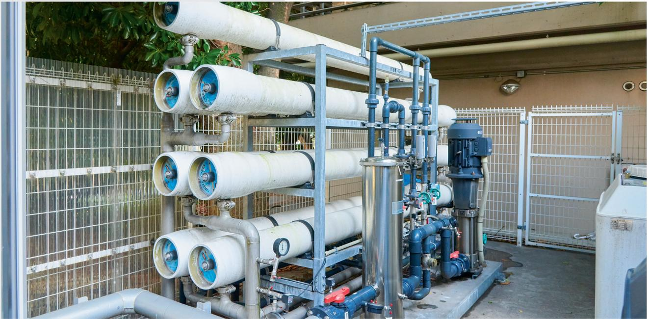
地下150mから汲み上げた井戸水を飲料水にする逆浸透膜(RO膜)システム。給水システムの電源は、災害時でも自家発電設備により供給が可能。
