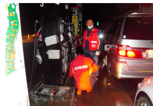
停電のサービスエリア。手動で給油した。
