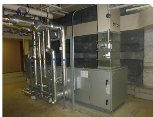
於：湯島地区の医科棟 ユニット形空気調和機の更新工事（左：施工前、右：完成）
