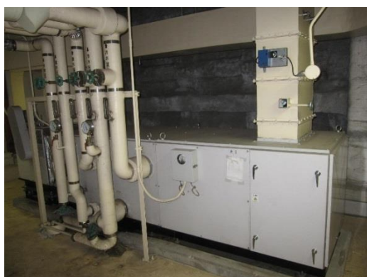
於：湯島地区の医科棟 ユニット形空気調和機の更新工事（左：施工前、右：完成）
