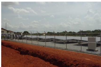
完成したソーラーパネル
